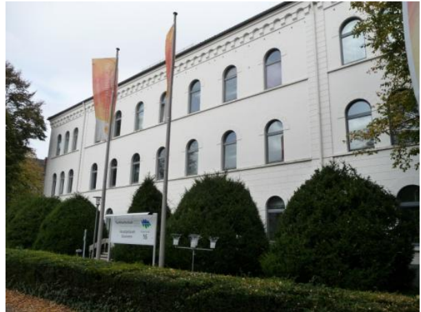
Jadehochschule Oldenburg Hauptgebäude
